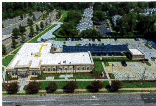
CMPD Hickory Grove, 76 kW, 2019
